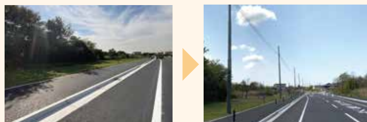
▲工事前 ▲工事後
